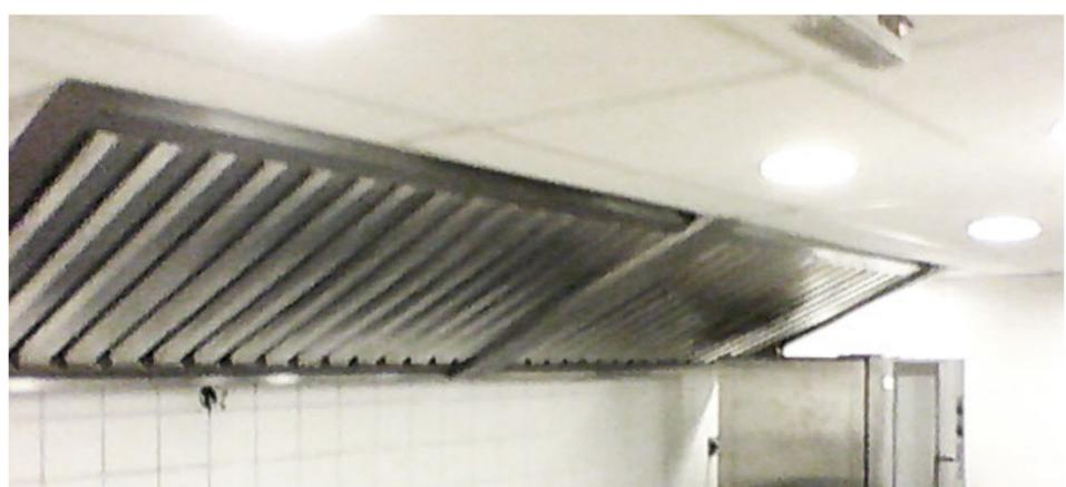
Em conformidade com normas ABNT NBR 14518:2019 e ASHRAE, também possui uma coifa com aspiração frontal ou lateral "Jet Blocker" e tecnologia Hayashi de jato de captura, garantindo alta eficiência na eliminação de odores e segurança com sistema antichamas.
